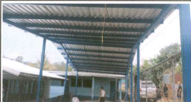
Foto1: Sustitución de lámina por lámina troquelada aluzinc calibre 26 80 M2
